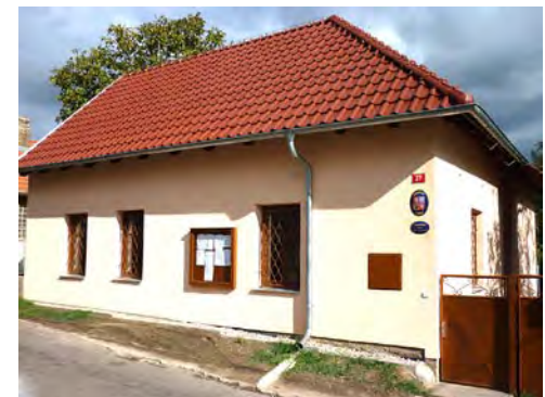
Budova OÚ Masojedy po rekonstrukci v roce 2011
